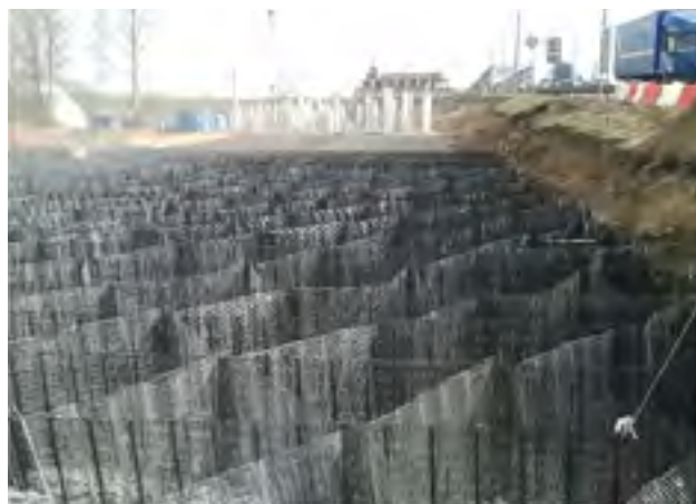
Рис. 4. Конструкция геосотового 3D-матраса
