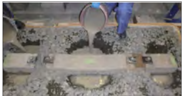
Рис. 3. Заливка супертонкодисперсного цементного раствора в балласт
