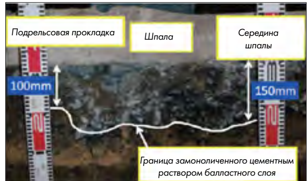
Рис. 4. Поперечное сечение замоноличенного цементным раствором слоя балласта
