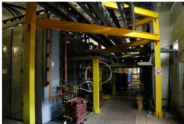
Рис. 4. Фото зала источников импульсного питания токамака КТМ с установленными ТП
