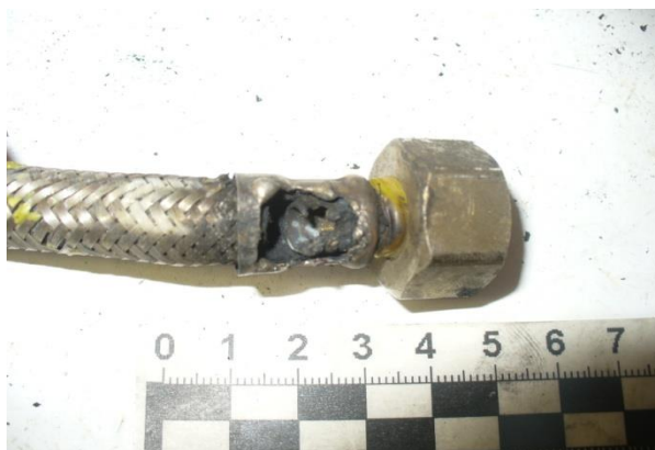
Рис. 1. Внешний вид повреждений гибкого газового шланга
