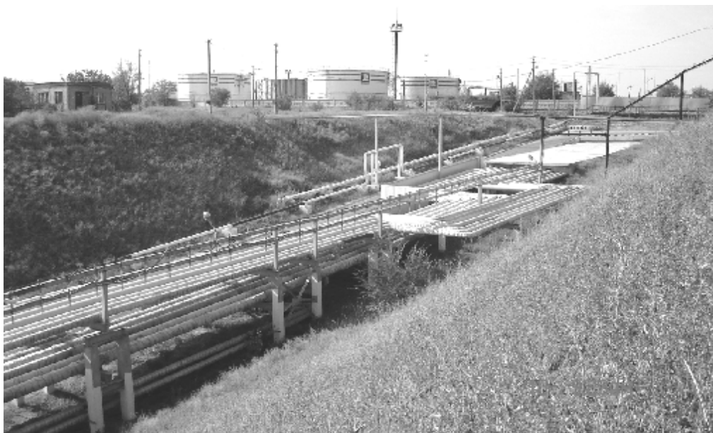
Рис. 3. Эстакадная линия от хранилища к нефтеналивному терминалу
